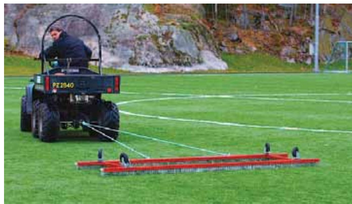
Overfladen løsnes og afrettes med børste. Det lugter ikke så rart når granulat og støv hvirvles op. Billedet er fra den norske vejledning 'Vedlikehold av kunstgressbaner'.
