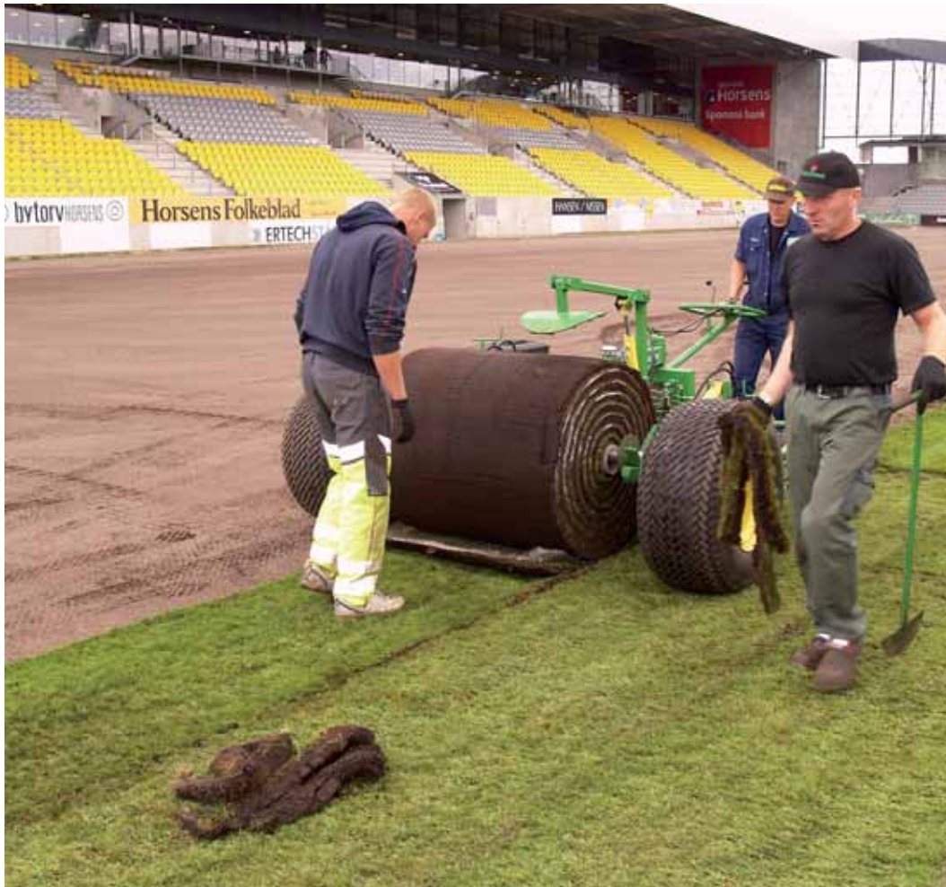
De 13 meter lange og 4 cm tykke 'Magnumruller' er ved at blive rullet. Foto: Prodana.
