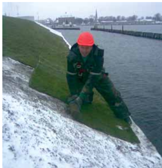
Der lægges rullegræs ud den 7. december iført livline og meget varmt tøj. Græsset selv tager ingen skade.
